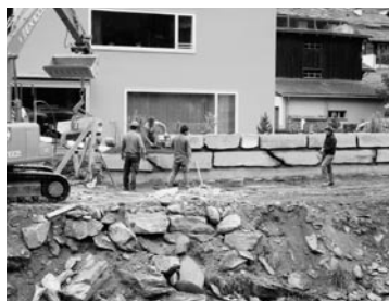
Bau der Brüstungsmauer
