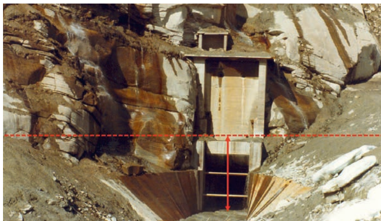
Die Grafik verdeutlicht die Sedimentablagerungen am Grundablass.
